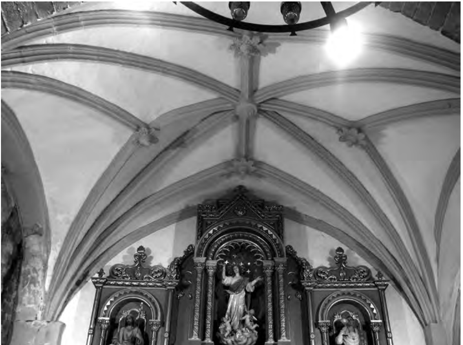
Fig. 12.- Volta estrellada a l'església de Vilagrassa (foto: J.Y.).
