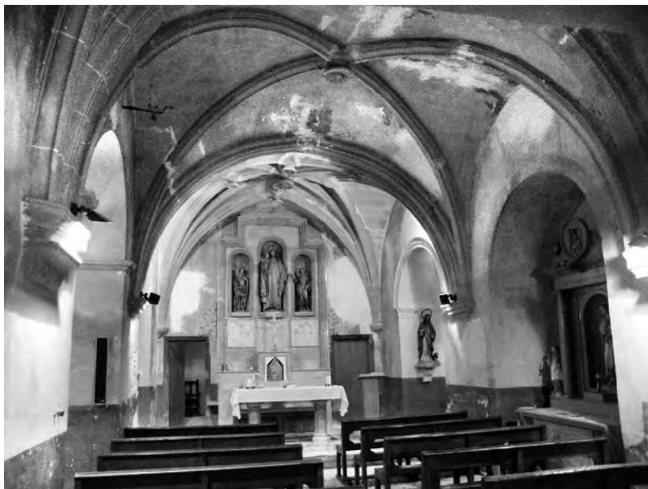
Fig. 9.- Interior de l'església de Llorenç, octubre de 2013 (foto: J.Y.).
