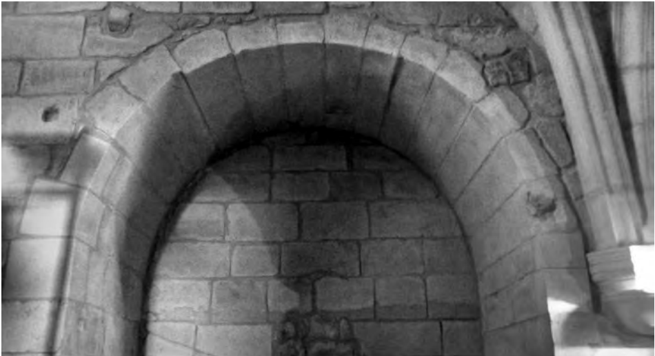
Fig. 17.- Capella lateral original de l'església de Llorenç (foto: J.Y.).
