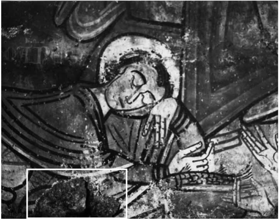
[Fig. 12] Detall de Sant Joan on s'aprecia la pedra vista del mur i el poc gruix del morter de preparació de les pintures originals.
