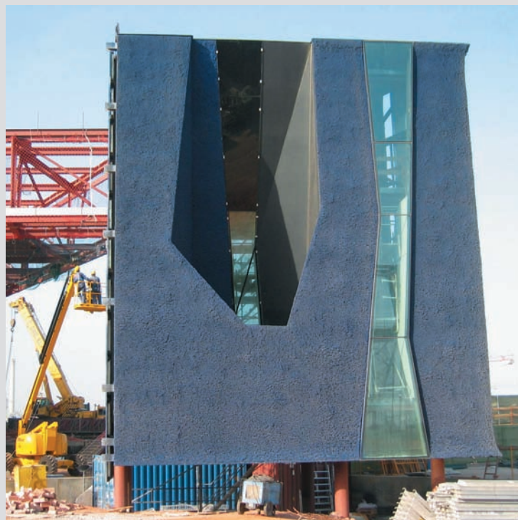
Prototip del tancament de la façana de l'edifici Centre de Convencions Internacional de Barcelona, CCIB / Prototype for the facing of the façade of the Barcelona International Convention Centre (CCIB), Barcelona : MAP Architects, Josep Lluís Mateo
