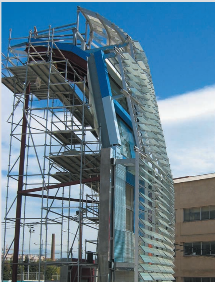
Prototip dels tancaments de les façanes de l'edifici Torre Llacuna - Immobiliària Colonial / Prototype for the facing of the façades of the Llacuna Tower-Immobiliària Colonial building, Barcelona : Taller de Arquitectos Colaboradores, Eduard Gascón
