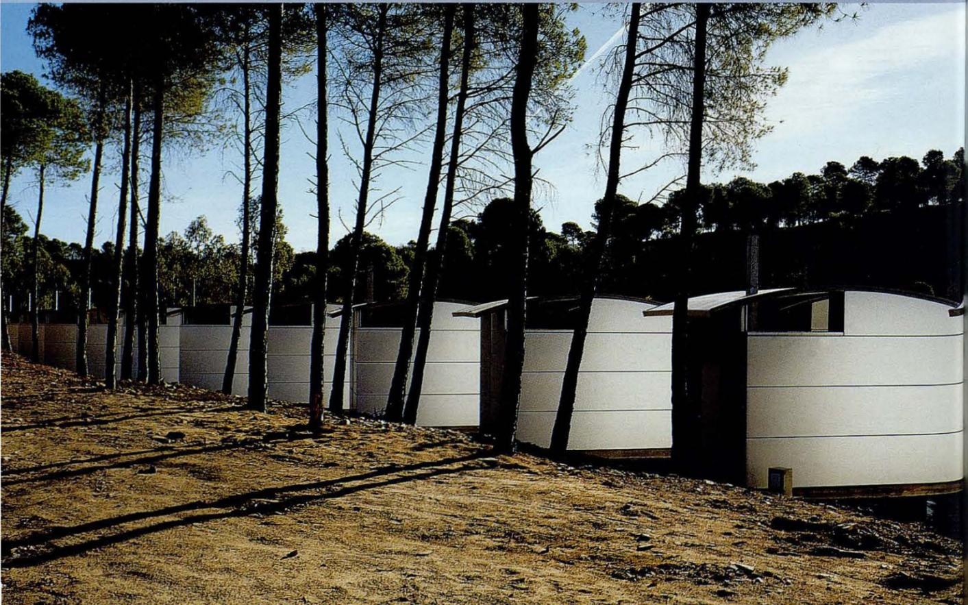
**CASETA PREFABRICADA I DESMONTABLE**, pot ser utilitzada com alberg temporal, tant per estades de vacances com d'emergència i, amb lleugeres modificacions en l'estructura interna, també és factible fer-ne ús com a quiosc de premsa, flors, etc.
