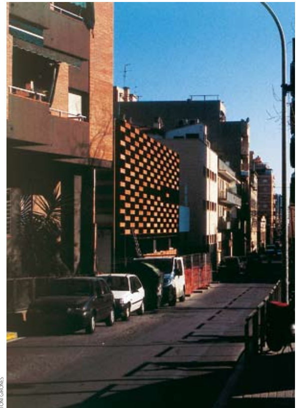
▶ Vestíbul sudoest planta primera i passatge interior
