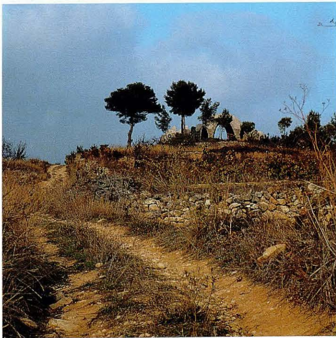
Vista del camí que porta al santuari i vista de la tanca inacabada que havia d'envoltar el recinte reproduint el perfil de Montserrat. En primer terme detall del somier emprat com a armadura.
