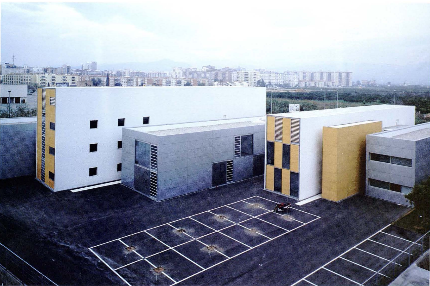
Façana posterior. Zona de càrrega i descàrrega. Rear façade. Unloading area.
