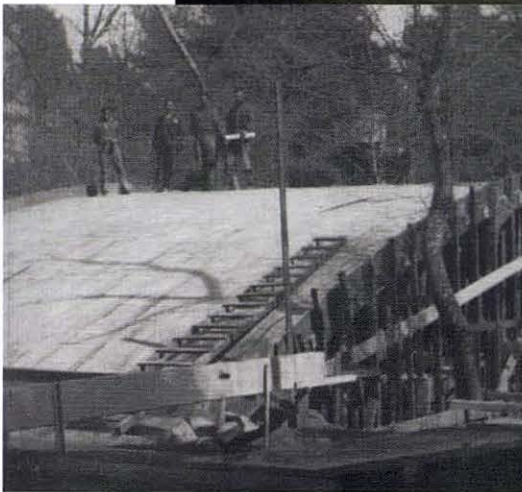
L'encofrat de la làmina corba The formwork of the curved slab
