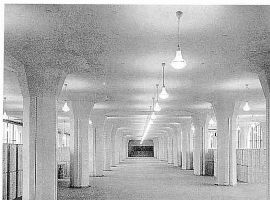
Sala de almacén. Store Room.
