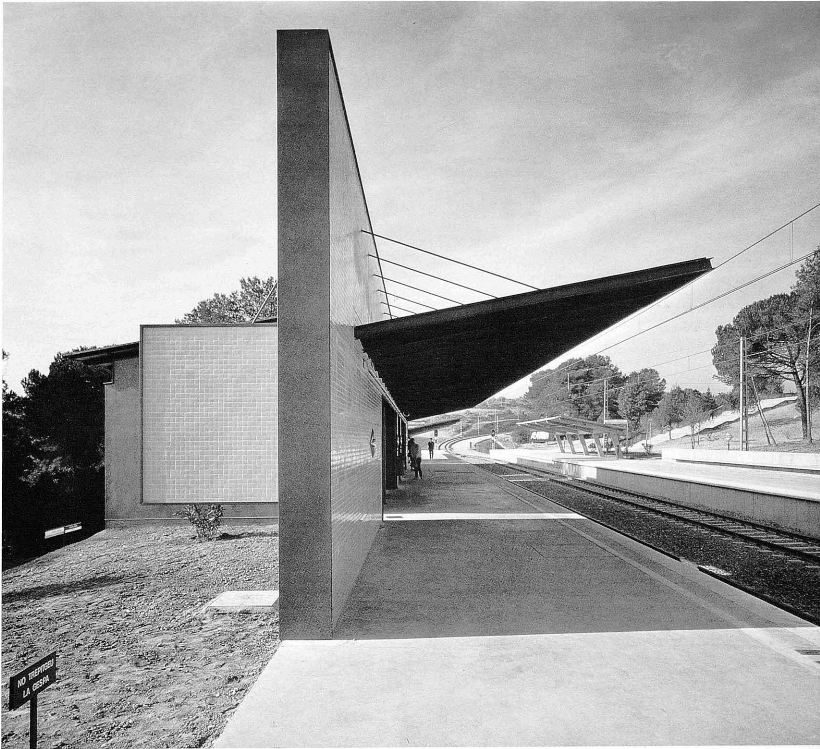
Vista en escorzo del muro con la marquesina y uno de los elementos de contrapeso.
