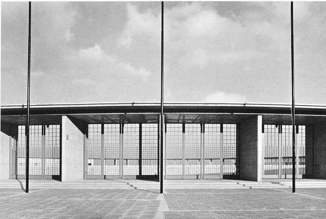
Vista de los accesos desde el exterior. View of accesses from the outside.
