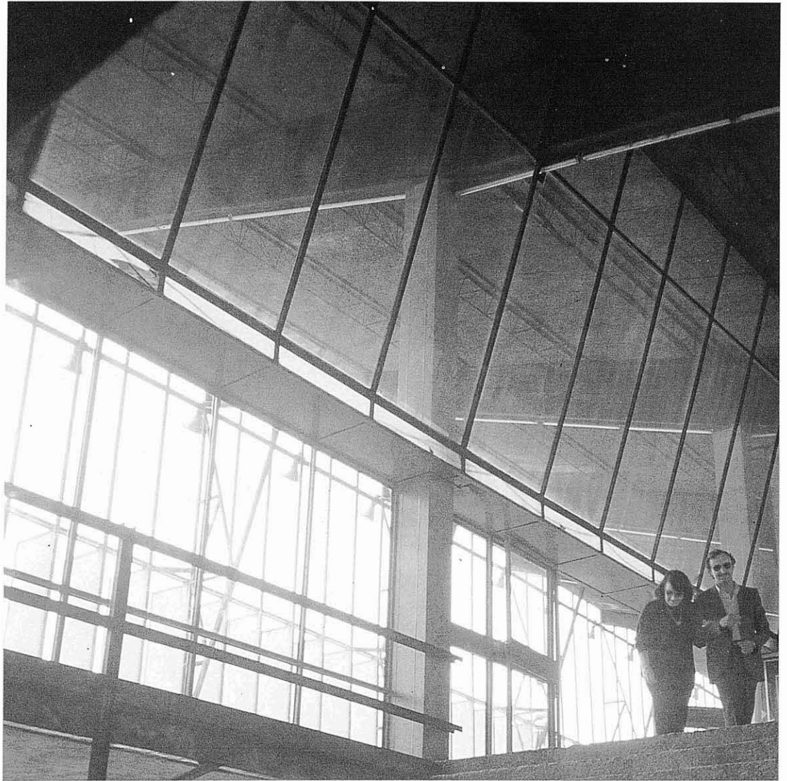
Vista del interior. Estado actual. Foto: Eduard Bru Interior View. Present State
