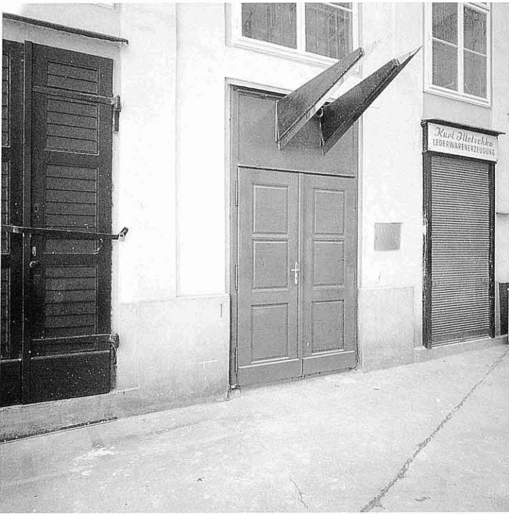
Puerta posterior al patio Rear Door to courtyard.
