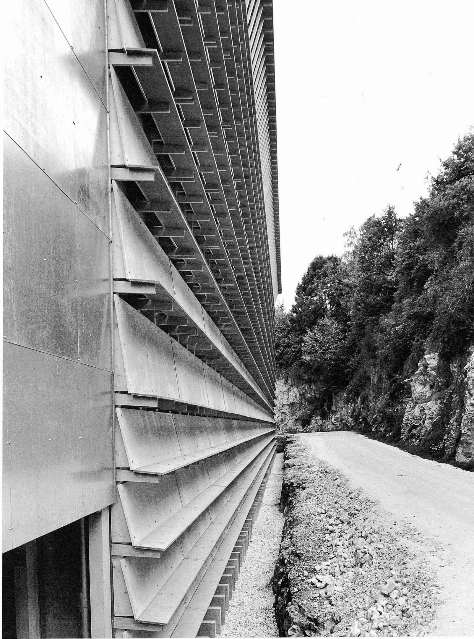
Fachada posterior en relación con la antigua pared de la cantera. Rear facade in relation to the old quarry wall.
