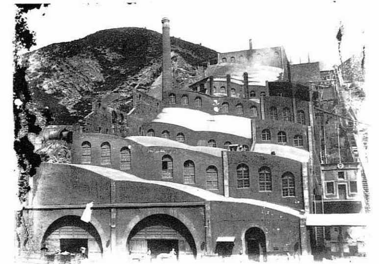
Fàbrica Asland de la Pobla de Lillet. Frontal de les naus construïdes. Foto: Arxiu Eduard Pujals. Asland Factory at Pobla de Lillet. Frontal View of the Bays Built.
