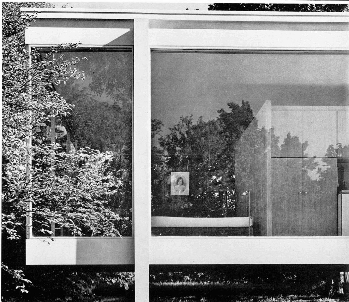
Casa Farnsworth. Mies van der Rohe. 1945-50.
