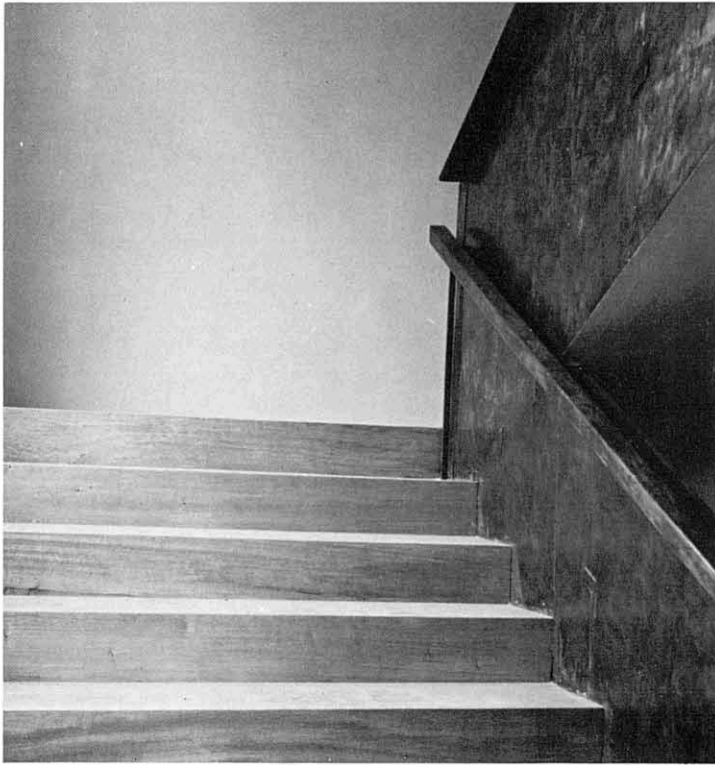
Escalera. Las barandillas son de cobre.
