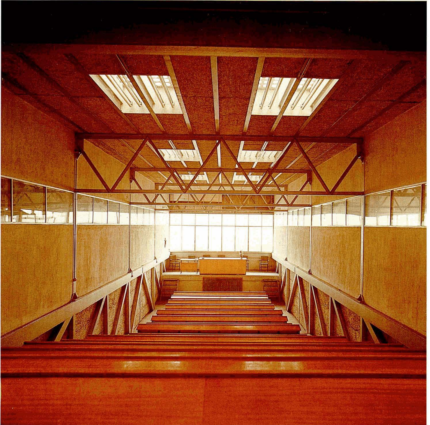
Interior del aula en las vigas.
