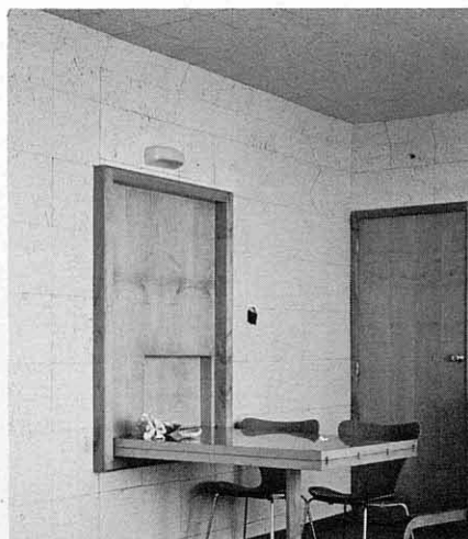
Casa en la Avda. de América (Madrid). 1966. (actual residencia del arquitecto). Comedor. Mesa abatible y extensible de madera de sicomoro. La presencia del piano en la estancia explica el revestimiento de placas aislantes en todos los paramentos.
