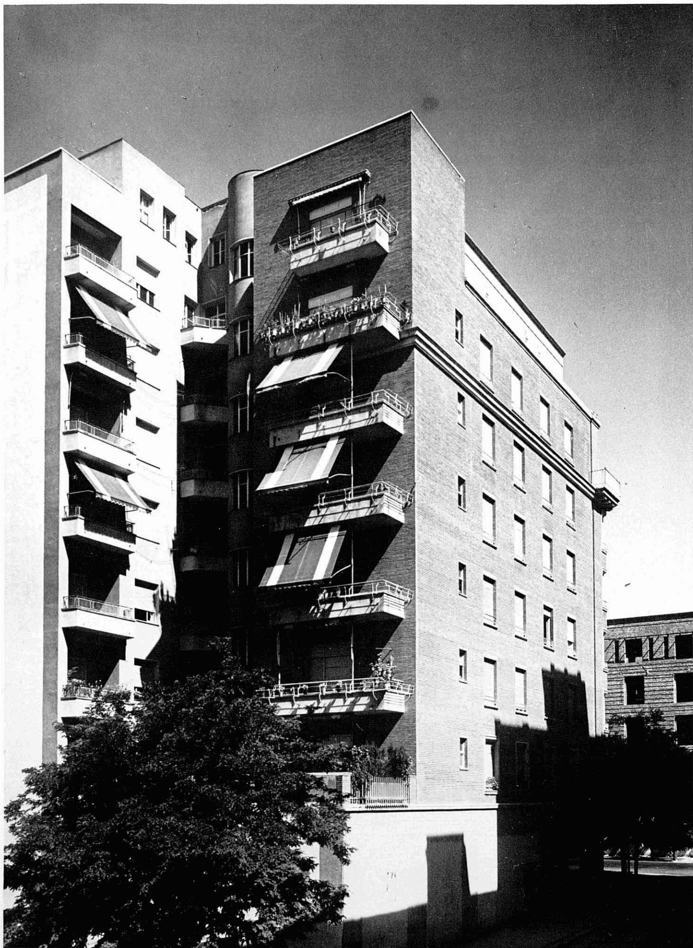
Fachada a la calle lateral y patio. Construida en cantería y ladrillo fino, sobre estructura general de hormigón armado.
