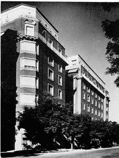
Fachada a la calle Lista.
