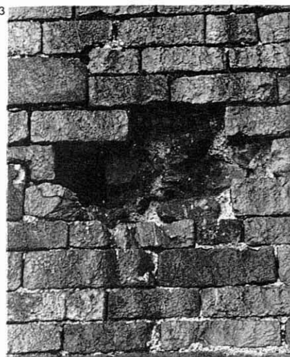
3. Als contraforts i als grans panys de mur és baix el percentatge de carreus front de la maçoneria presa amb morter de calç...
