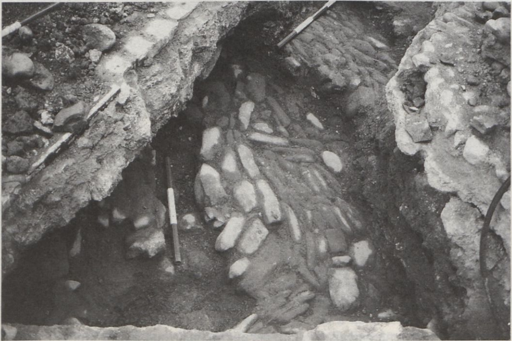
Excavació al carrer del Pont Vell. Successió de paviments, el més antic datable dels s. XIII-XIV.
