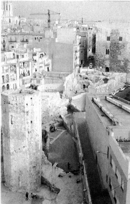
Figura 17. Vista del sector des del sud. En primer terme, la Torre de les Monges, del segle XIV, i les restes del Baluard del s. XVI.
