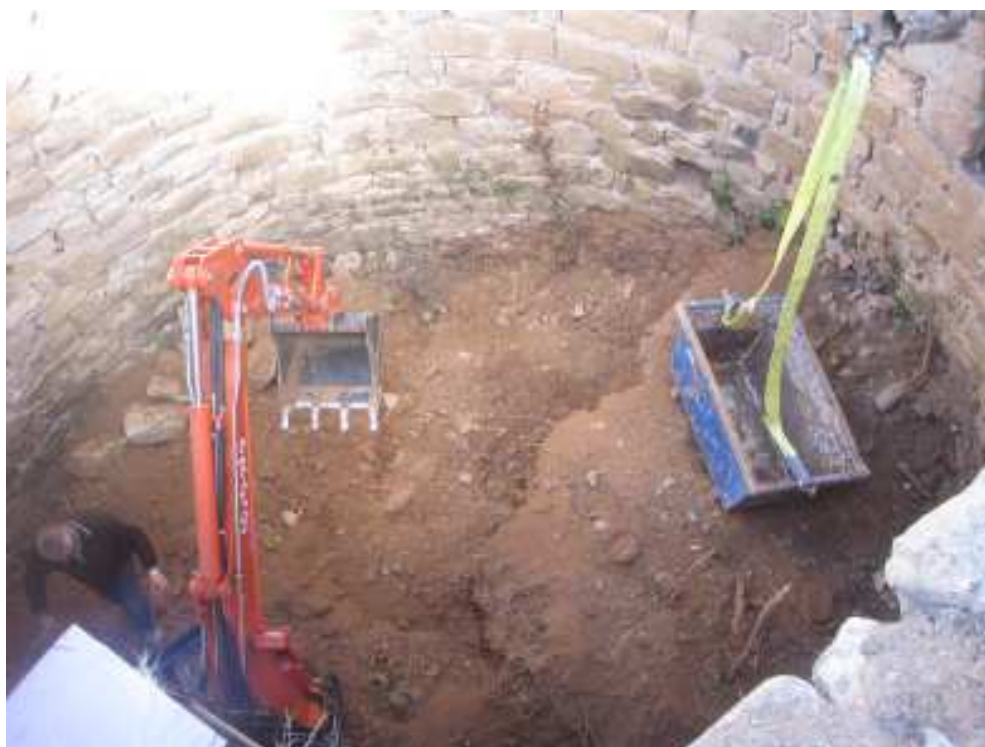
Foto 2. A la imatge superior podem veure la petita màquina giratòria i el cubilot en el que s'introduïen els sediments.
