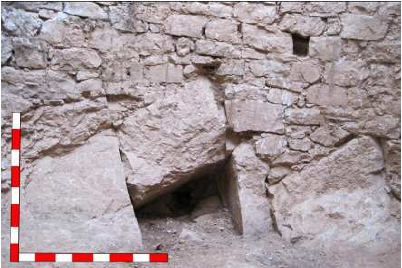
Fotografia 14: Imatge de l'obertura del desaignament. La mesura mètrica amida 2 metres.
