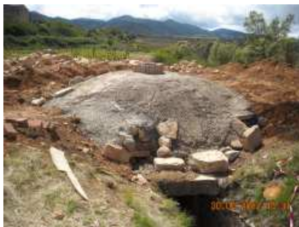
Fotografies 27 i 28: Imatges del procés de reconstrucció de la cúpula del pou. A l'esquerra veiem el cimbre de fusta i a la dreta la cúpula del pou abans de recobrir-la de pedra i terra.
