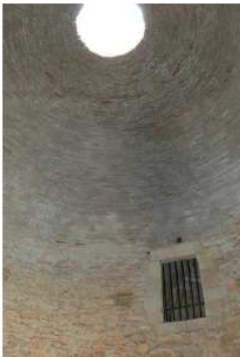
Foto 11. A l'esquerra tenim una imatge de la cúpula del pou de gel del monestir de Poblet. S'hi pot apreciar un orifici per accedir-hi i treure el gel quan el pou es trobava molt ple. Tanmateix, és interessant fixar-se que la tècnica constructiva de la cúpula està construïda amb maons, que li conferien més lleugeresa. Per altra banda, a la part inferior dreta de la imatge, hi veiem l'accés al pou, conformat per pedra escairada, molt similar a la documentada al pou de gel de la Granja Mitjana (imatge extreta de la web del Consell Comarcal de la Conca de Barberà http://patrimoni.serviconca.org/ ).
