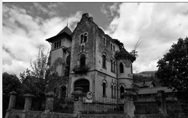
Torre Can Roig, Camprodon (c. Freixenet, 21) en estat ruïnós.
