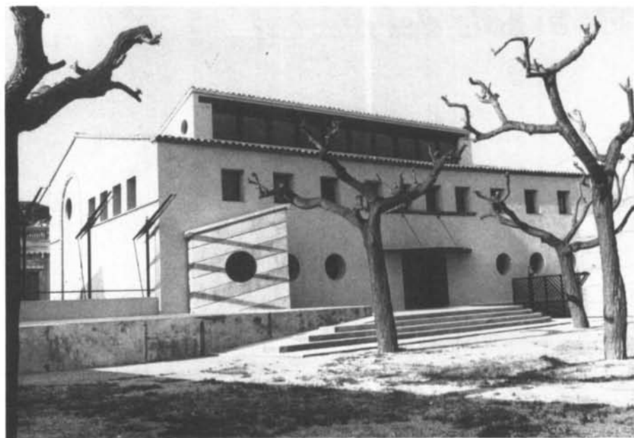
Les Escoles Velles, edifici que ha estat restaurat per encobrir-hi el Centre Cultural de Begur. A la pàgina anterior, la biblioteca del Centre.
