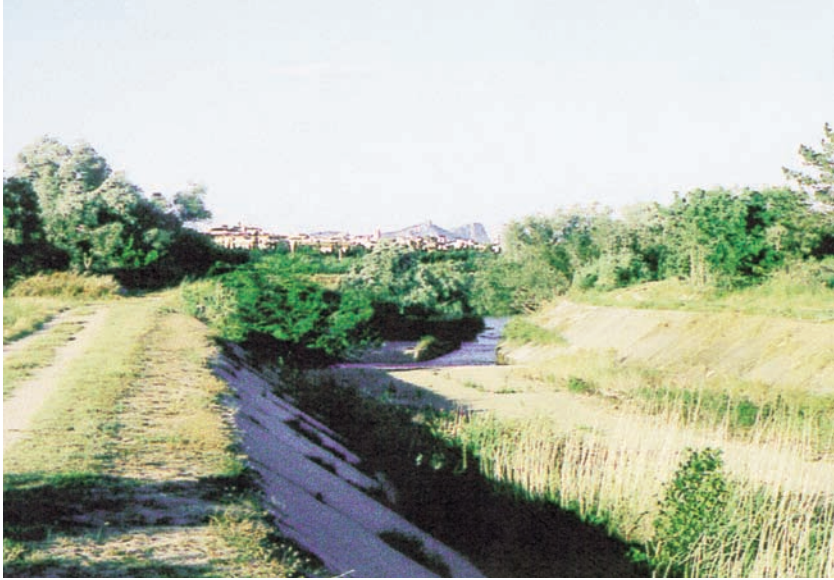
Canalització amb formigó del tram baix del riu Daró quan s'uneix amb el Ter
