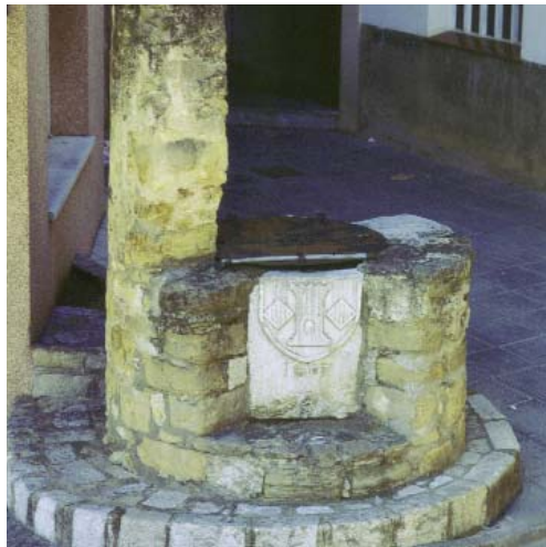
Pou públic a Torroella de Montgrí, al carrer de Mar
