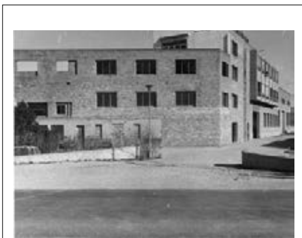
17. Fàbrica de Construcciones Alfaro SA, situada prop de la Riera de Caldes.
