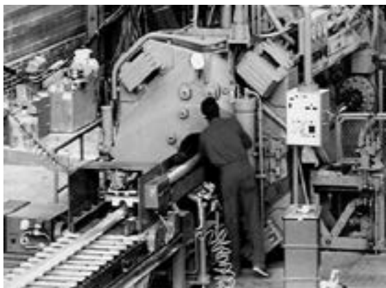
10. 1969. Premsa Schloemann per a la fabricació del tub d'alumini pel sistema d'extrusió.
