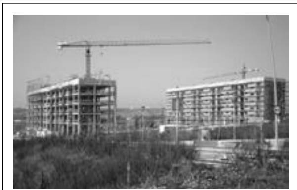
45. Construcció, malgrat la crisi, dels primers blocs de pisos a Can Filuà. A primera vista, crida l’atenció la seva alçària que no s’adiu amb l’entorn, contrasta molt amb la dels pisos de Mas Costa i contradiu el projecte de ciutat-camp que pretén el PGOU.
