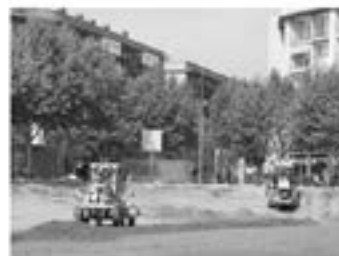
Comencen les obres del futur Parc Central (oct. 2012)
