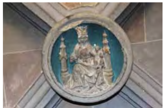
Fot. 14. Estat de la clau de volta
