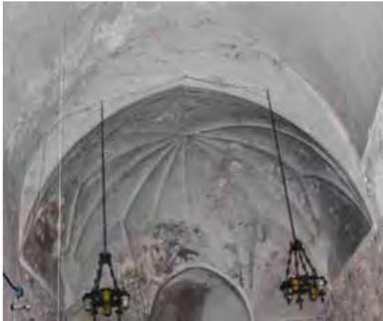
Fot. 6a. Estat inicial de l'absis i el timpà
