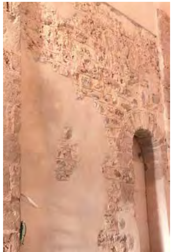
Fot. 22. Detall dels encintats, resultat final.
