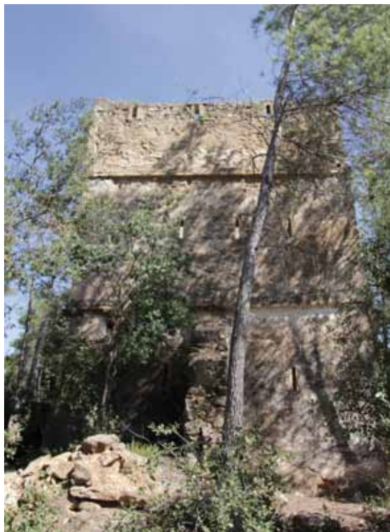
Façana lateral (Sud-oest). A la meitat de la planta baixa arrenca un dels murs de tancament del cos defensiu que protegeix la meitat de la torre
