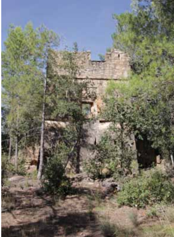
Façana principal amb la porta d'entrada a la torre (Sud-est) 68
