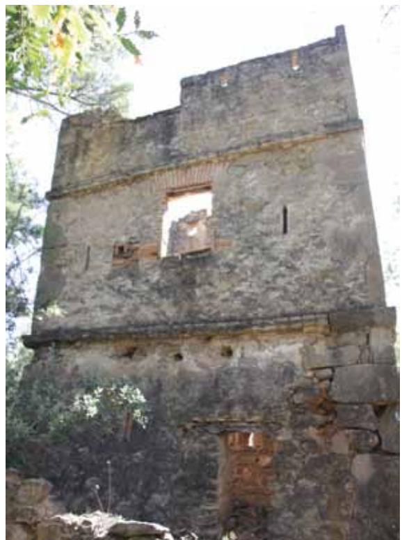
Façana posterior (Nord-oest). Té una finestra en el primer pis i, a la planta inferior, la porta d'entrada des del cos defensiu. En primer terme, es veu un fragment de la paret que tanca aquesta petita estructura militar
