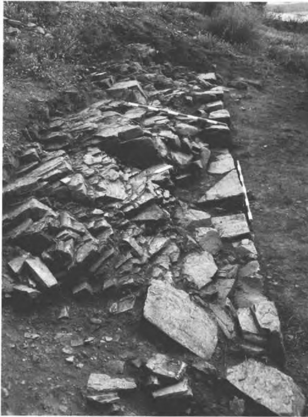
Fig. 16: Imatge del pany de muralla sud. Es pot apreciar com aprofita la roca mare per tal de bastir-se des de la fonamentació.
