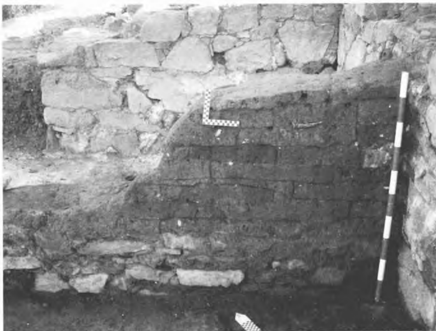
Fig. 12: Detall de la zona més ben conservada del mur de tàpia ubicat a l'àmbit 5.
