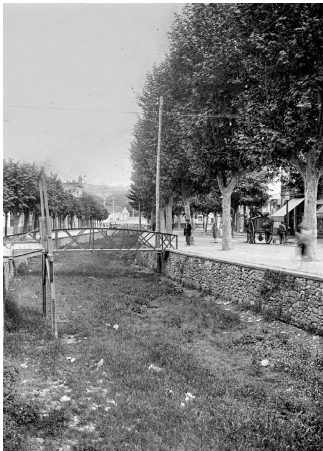
Figura 11. En primer terme, estrada de fusta per a actes a la plaça de Catalunya. En segon terme, pont de ferro de l'Ateneu, i al final, pont de ferro de Lestonnac. Foto: família Ribas i Camp
