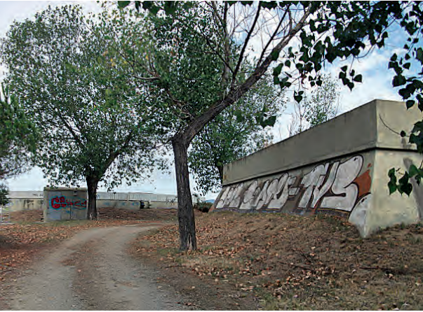
Figura 4. Dipòsits d'aigua en els Pinetons. El rectangular, de 1.000 m 3 , construït l'any 1970, i el circular, de 2.000 m 3 , construït l'any 1978. Foto: A. Collado
