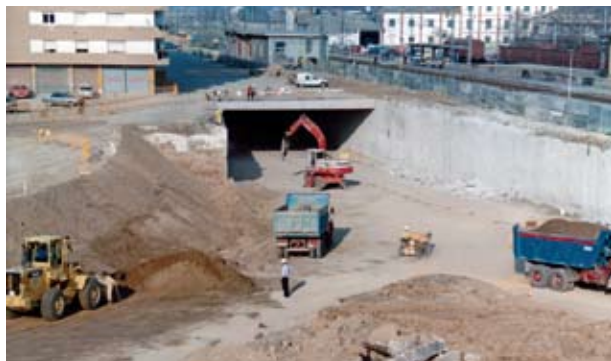
Figura 4. Obres de la construcció de la variant de la N-152, ara C-17. (Tribuna Vallesana. Arxiu Històric de Mollet)
