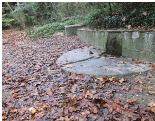
Figura 21. Mina de la font de la Mercè
