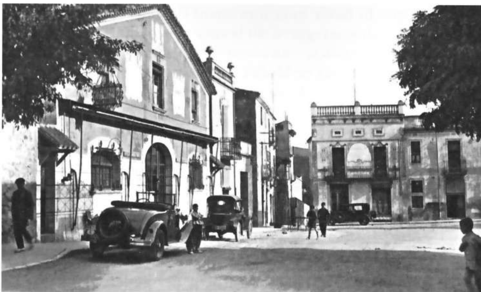
Plaça Mercadal, on es va construir un refugi de rasa al final de la guerra.
