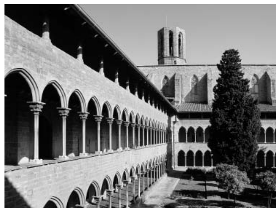
El claustre de Pedralbes consta de dues galeries amb una successió d'arcs de mig punt; la primera aixecada al llarg del segle XIV i la segona, durant els primers anys del segle següent. Un darrer es va edificar al segle XVI per tal de protegir les anteriors de les aigües de la coberta (Foto: Pere Vivas i Jordi Puig, Triangle postals, 2007).
