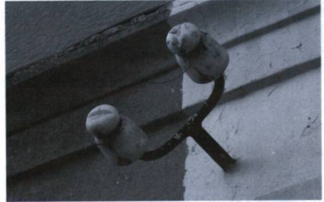
Aïlladors probablement anteriors a 1920, existents actualment en façanes moianeses (fot. R. Tarter)
