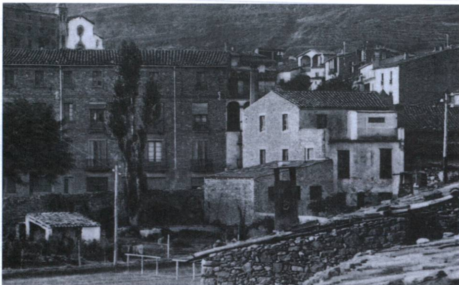
La línia elèctrica que baixava des de l'edifici de la Central, al seu pas per la plaça del Colom i l'«hort del rector», probablement el mateix any 1907 en què fou instal·lada (fot. L. Roca)
