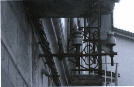
Aïlladors probablement anteriors a 1920, existents actualment en façanes moianeses (fot. R. Tarter)
