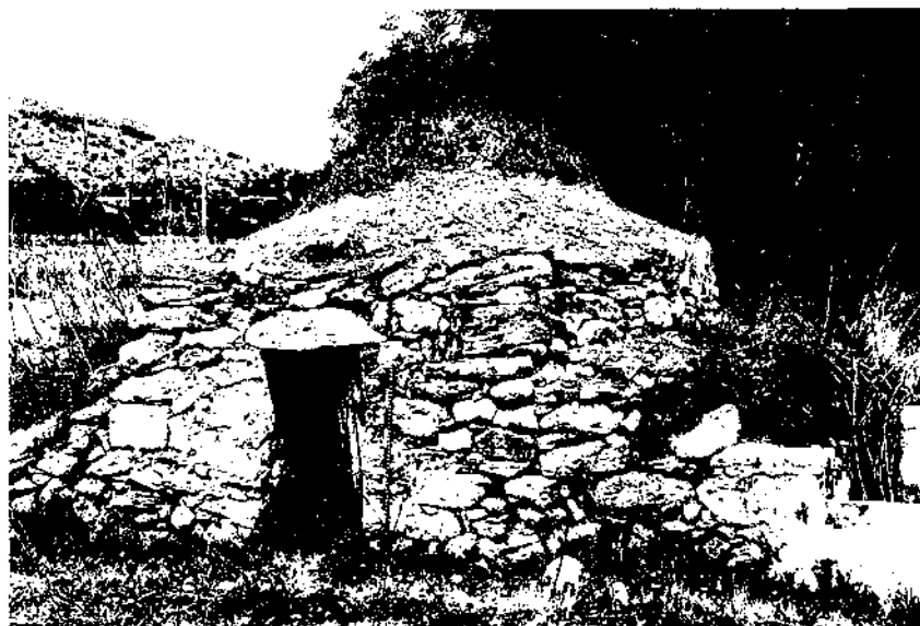
Fotografia 3. Barraca amb reforç exterior perimetral, un safareig i marges adossats a ambdós costats, arrebossat de ciment a la façana (amb la data 1908) i als muntants i lliris a la coberta (construcció núm. 44).
