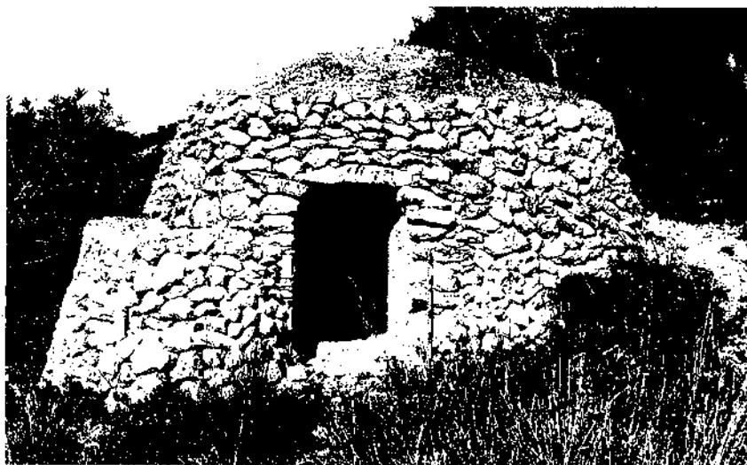
Fotografia 1. Barraqueta amb un reforçament en un dels costats i amb un llindar i un arrebossat de ciment al corredor, per acollir una porta actualment desapareguda (construcció núm. 31).
