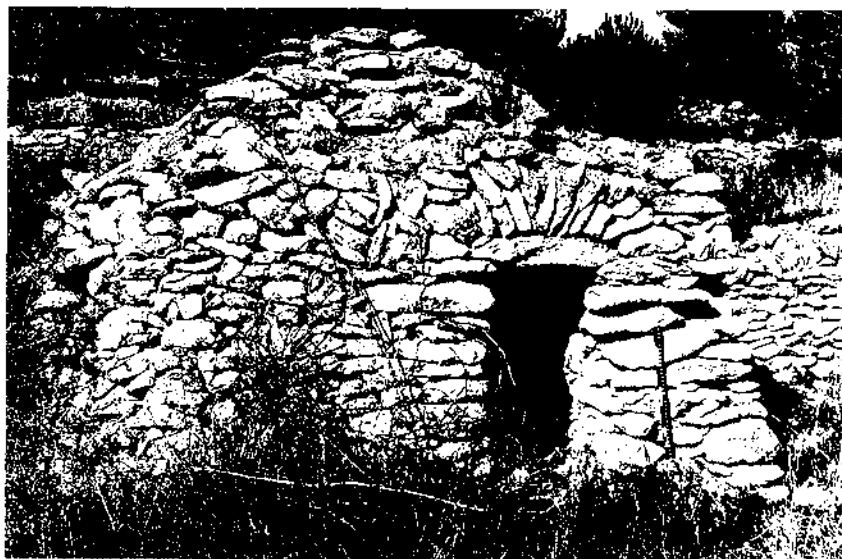
Fotografia 2. Barraqueta adossada a un marge, amb llinda mixta i coberta molt erosionada (construcció núm. 9).
