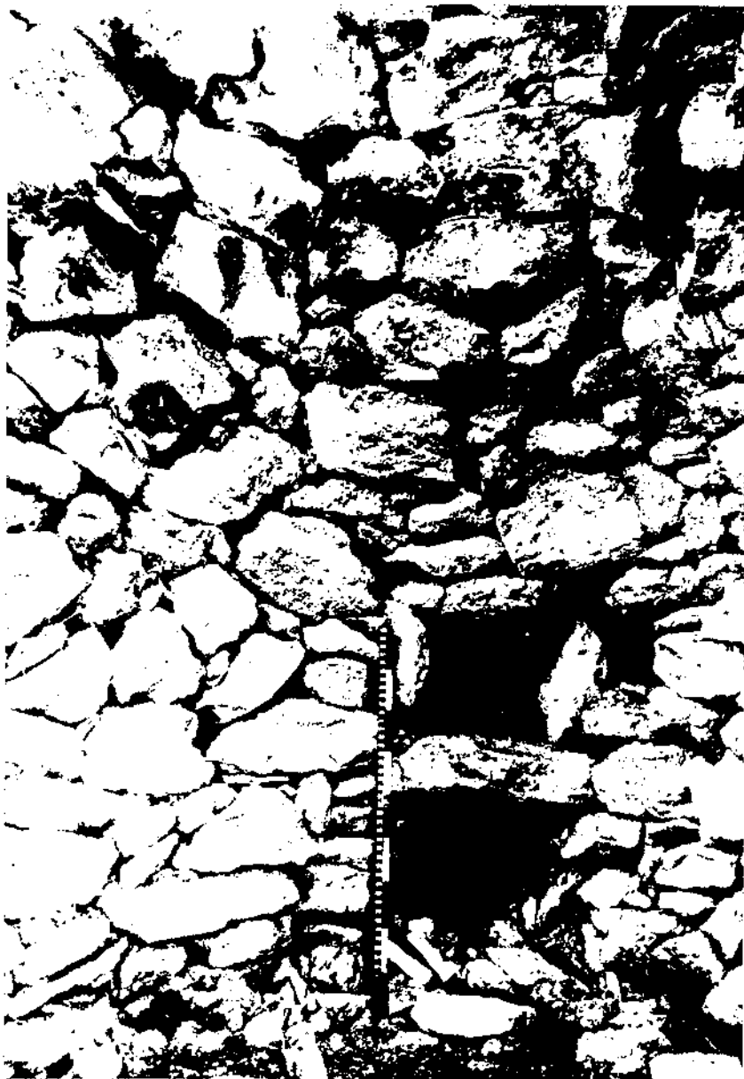
Fotografia 6. Dues repises sobreposades a l'interior d'una barraca amb la cúpula ensorrada (construcció núm. 2).
