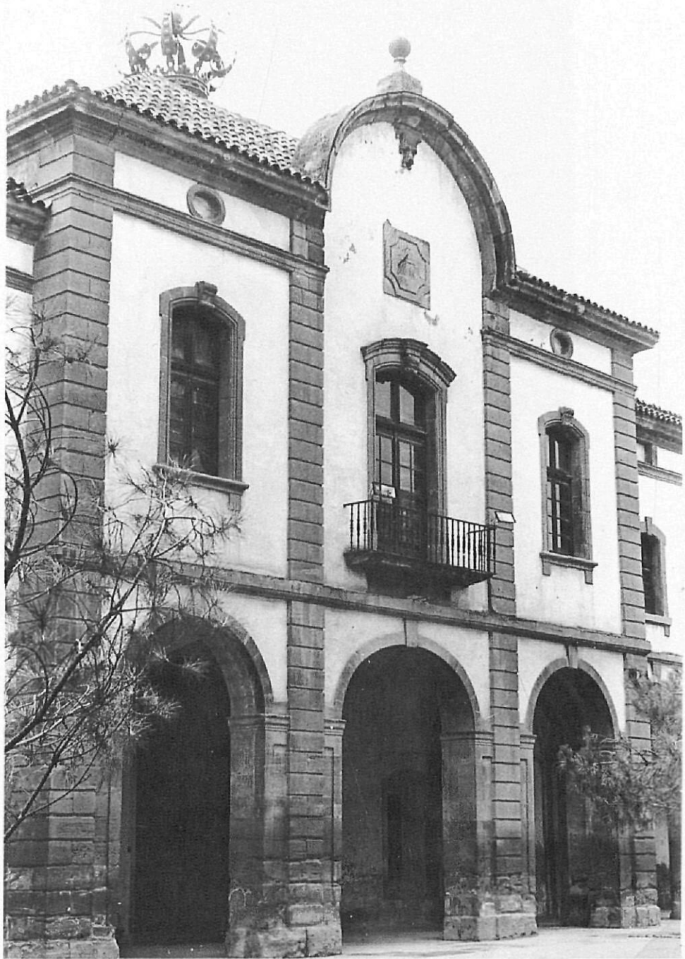
Contrafaçana interior. Una bella façana austera, pròpia del llenguatge dels enginyers, que ens recorda façanes com la de l'església de la Ciudadella i la part central del Col·legi de Cirurgia de Barcelona.
