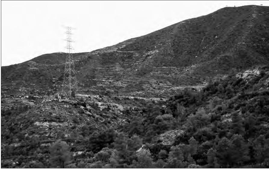
Fig. 22. Els espais naturals de Ribera-roja, i de la Ribera d'Ebre, presenten una gran densitat de línies elèctriques per la proximitat de diferents fonts de producció elèctrica (2010)
