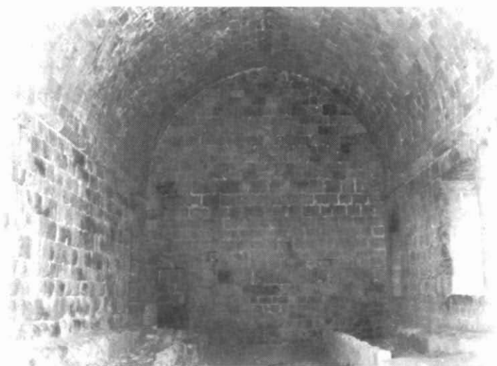
CASTELL DE MIRAVET. Les anomenades «quadres» o saló principal - S. XIII.
