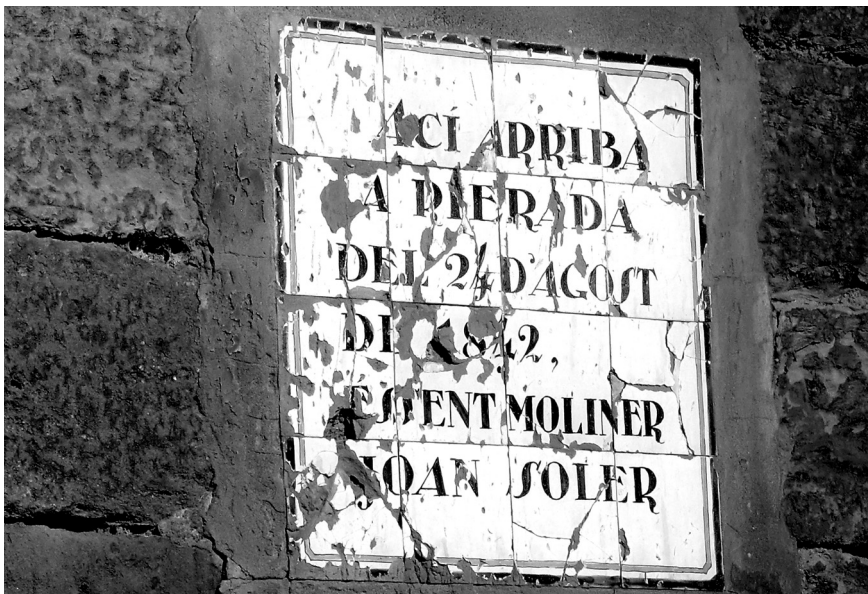
Fotografia 3. Placa situada a la paret sud del Molí de l'Abadia recordant l'aiguat de Sant Bartomeu.
