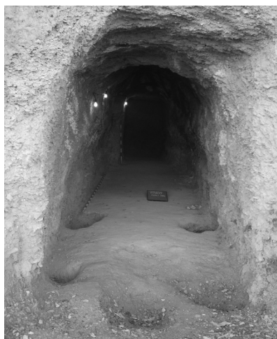
10. Boca del refugi antiaeri integral amb els forats de l'estructura de fusta que van construir a l'entrada per protegir-la.
