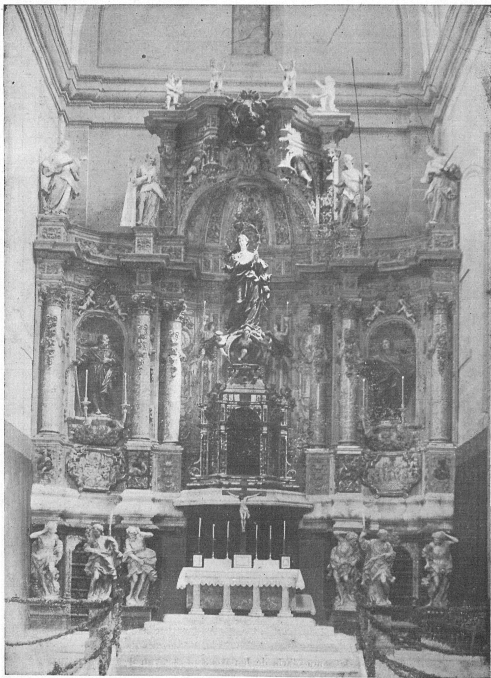
Estado actual (1947) de la restauración del retablo basilical de S. María de Igualada
