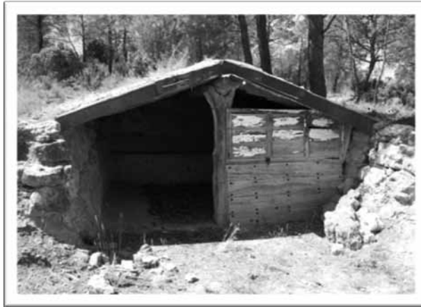
FIGURA 3. Las barracas solían mezclar los materiales constructivos, como la piedra y la madera.
