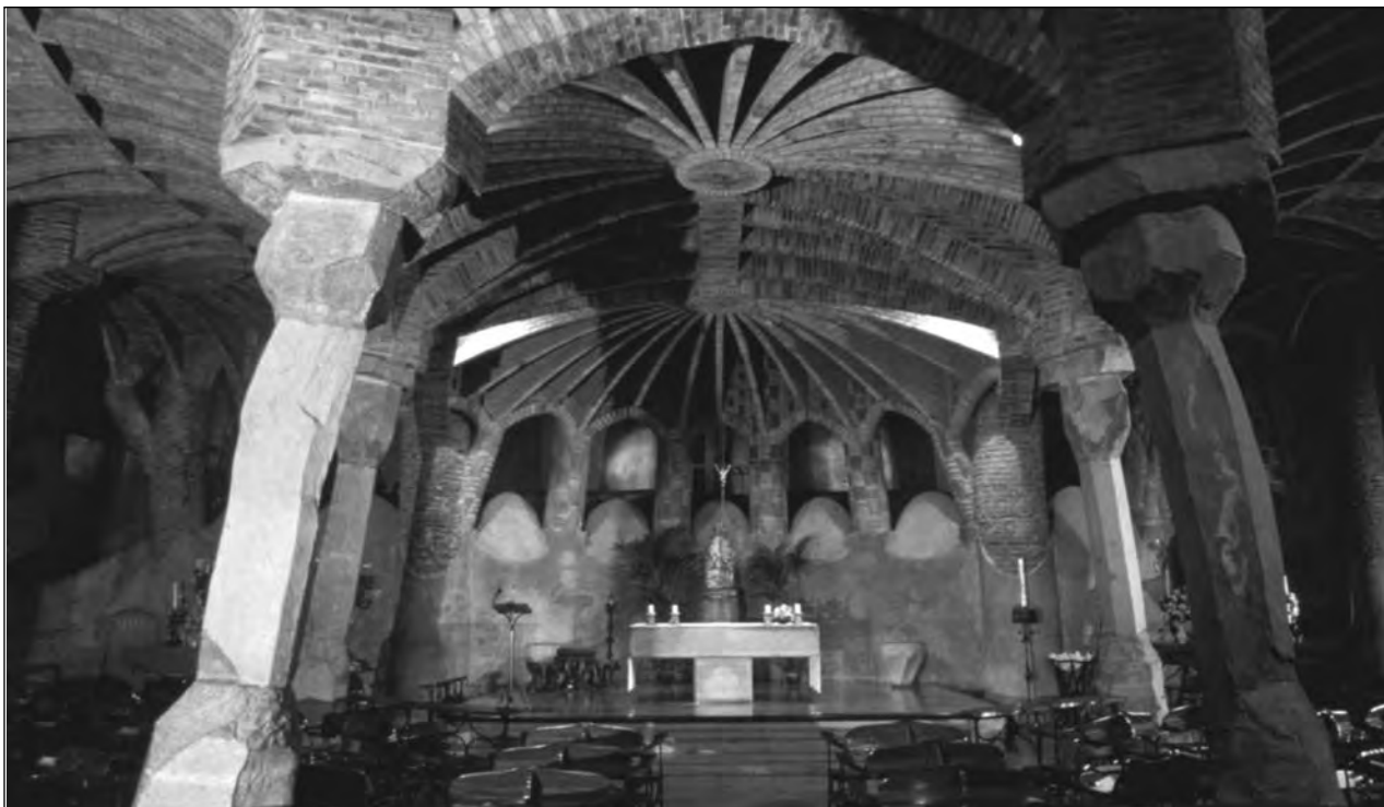
Interior de la cripta. Antoni Gaudí, Colònia Güell (Santa Coloma de Cervelló). Fot. Francesc Muntada
