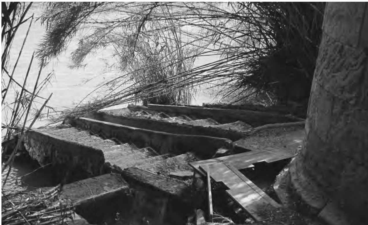
Sobreixidor de l'aigua des de la sala de banys cap al riu Llobregat. Fot. Vicenç Salamero i Guàrdia
