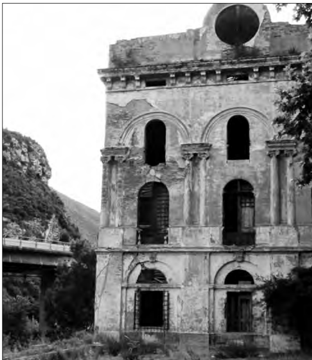
Façana del cos lateral. Al soterrani hi ha la galeria de banys. A l'esquerra es pot veure el pont de la carretera d'Abrera a Manresa. Fot. Vicenç Salamero i Guàrdia
