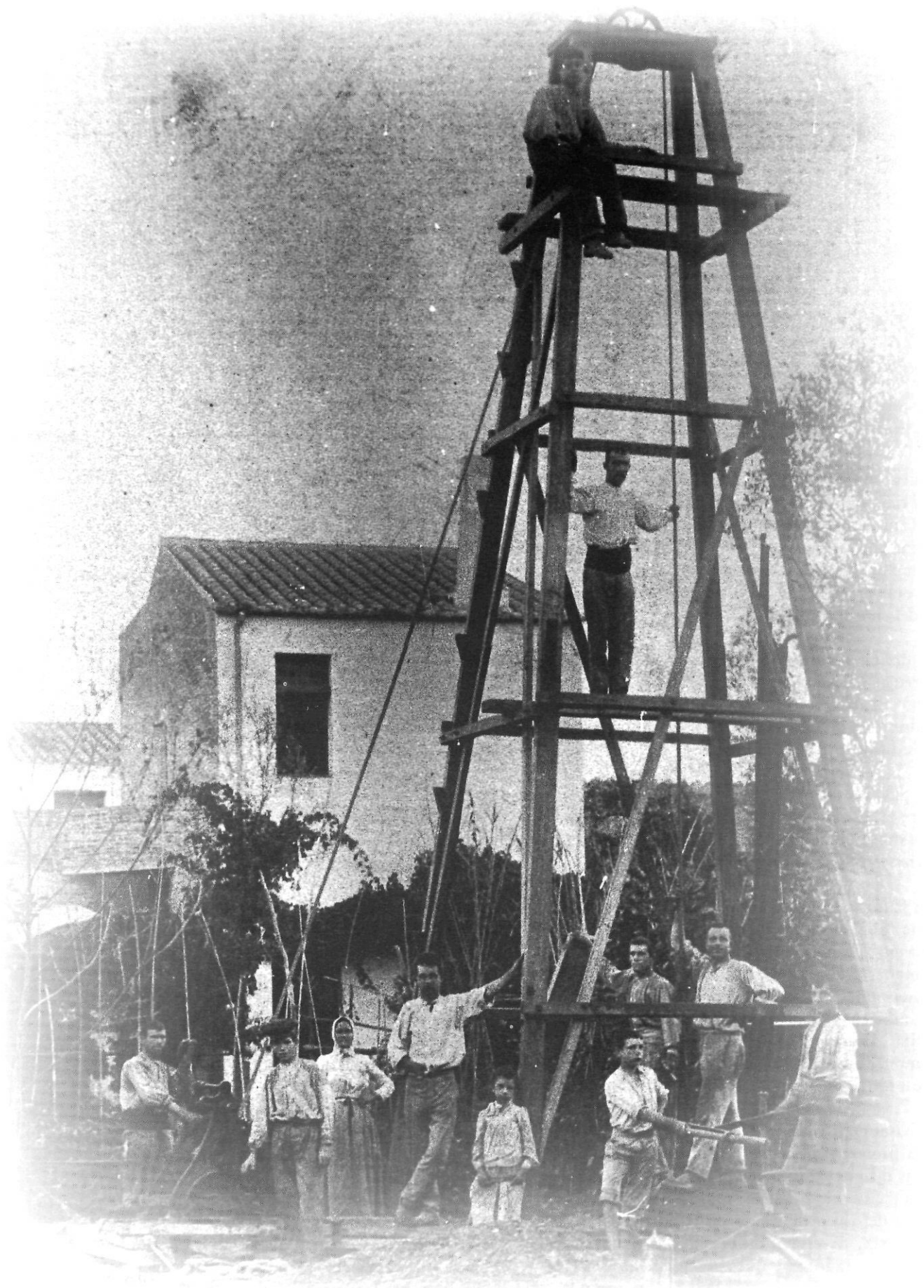
Perforació d'un dels primitius pous artesians al nucli urbà d'El Prat (1904). Font: Reproducció de FERRET I PUJOL J.: Primer centenari del descobriment de les aigües artesianes del delta del riu Llobregat (1893-1993), Comissió d'Usuaris del Delta del Riu Llobregat, El Prat de Llobregat: 1993.
