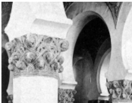
6. Estat actual d'un capitell original. Fotografia de l'autor, de 1997.
