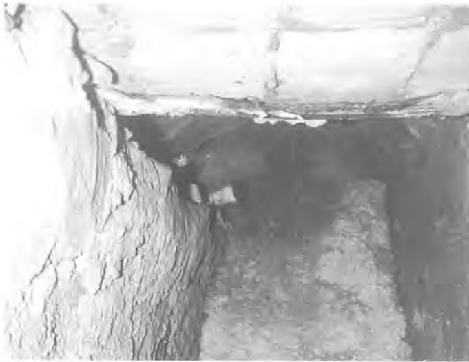
Coll de mina tallat per formigó provinent dels fonaments d'una nova edificació.
